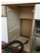
①キャビネット解体後
