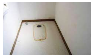
①便器解体・撤去
