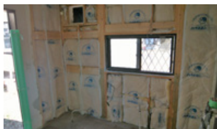
①キッチン解体後
