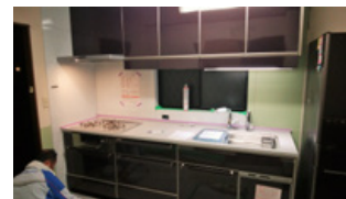
④キッチン取付中
