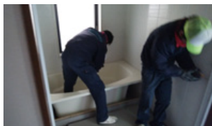
①浴室解体中
