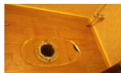
①便器解体・撤去
