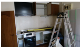
①キッチン解体中
