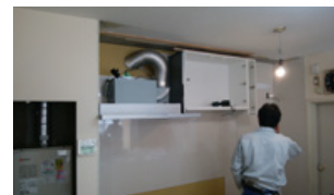
④キッチン取付中
