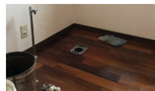
①便器撤去後
